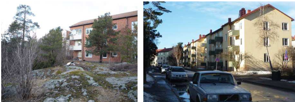
Exempel på befintlig bebyggelse på Hägerstensåsen
