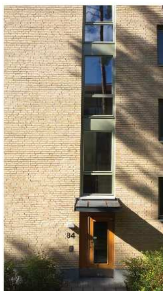
Fönster i trapphus
