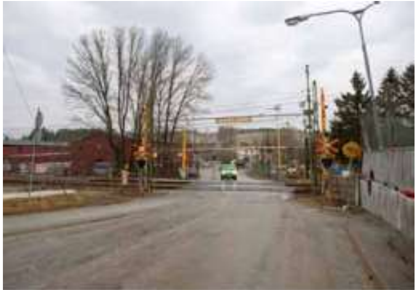
Bild 4. Sulkyvägens nuvarande plankorsning.
