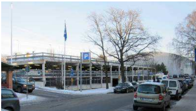
På Linneduken 4 vid Klädesvägen har Stockholm Parkering ett parkeringsdäck för bl a infartsparkering, som avses ersättas med ett nytt bostadshus. Bakom p-däcket syns tillfälliga bollhallar i Linneduken 1, som kommer att ersättas med nya bostadshus enligt en detaljplan som vann laga kraft 2013-01-24.
