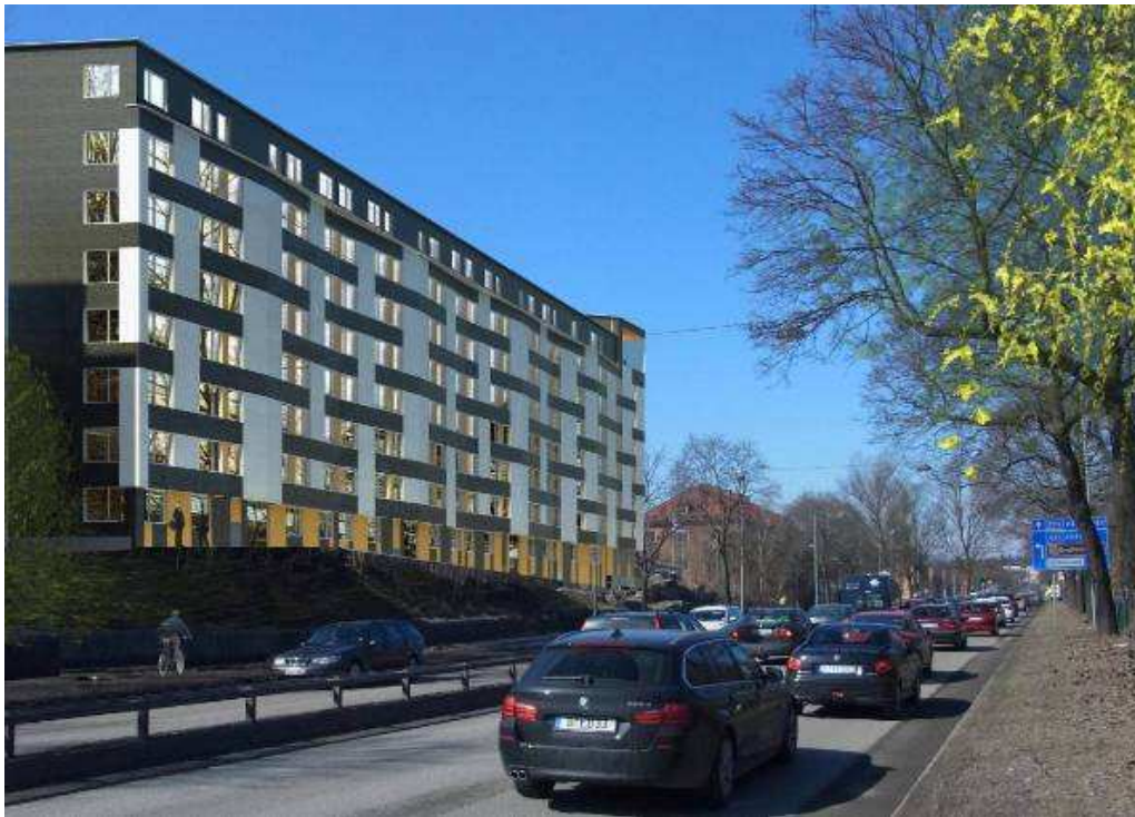
Fasaden på Linneduken 4 mot Drottningholmavägen, sedd från öster
