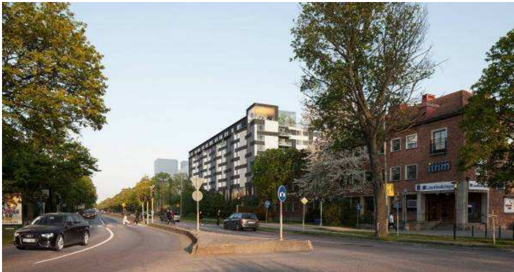
Linneduken 4 mot Drottningholmsvägen sedd från Brommaplansrondellen. Fasaderna har en storskalig mönster- och reliefverkan och byggnadens nordvästra hörn accentueras genom en uppglasad tornpåbyggnad, som ligger intill den gemensamma takterrassen och fungerar som gemensamhetslokal för de boende.
