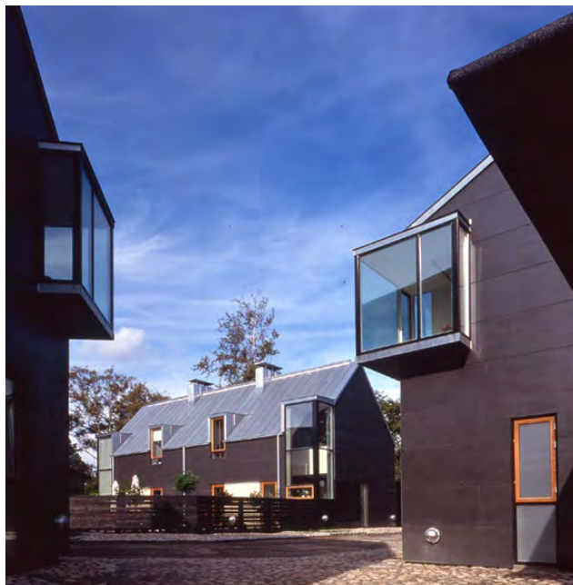
Referensbild: fibercementskivor som fasadmateriäl Brf Tre Gudor. Källa: HSB Helsingborg
