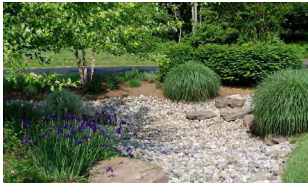
Exempel på vegetation i infiltrationsbädd som inspiration till LOD-dikemagasin
