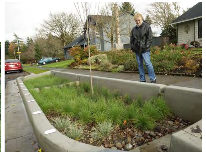
Exempel på vegetation i infiltrationsbädd som inspiration till LOD-dikemagasin
