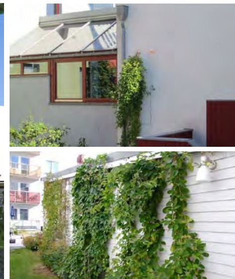
Två exempel fasadvegetation. Källa: Veg Tech AB
