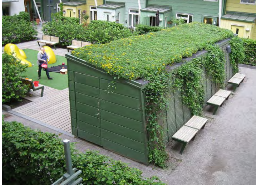
Referensbild fasadvegetation. Källa: Veg Tech AB
