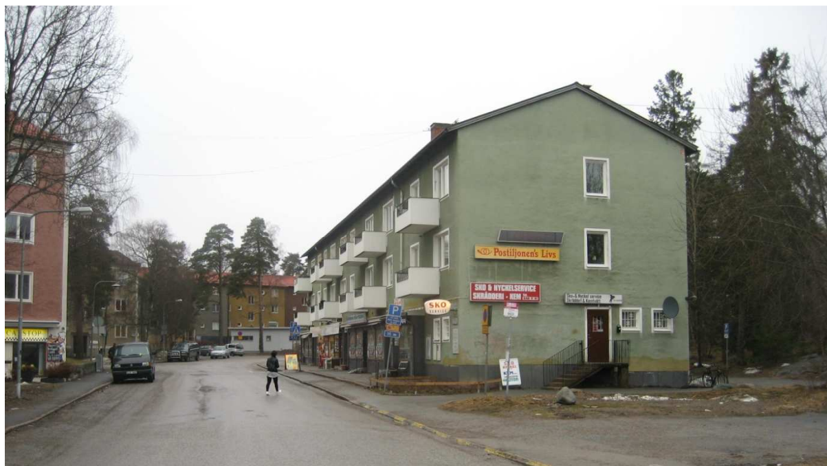
Centrumkvarteret vid Postiljonsvägen
