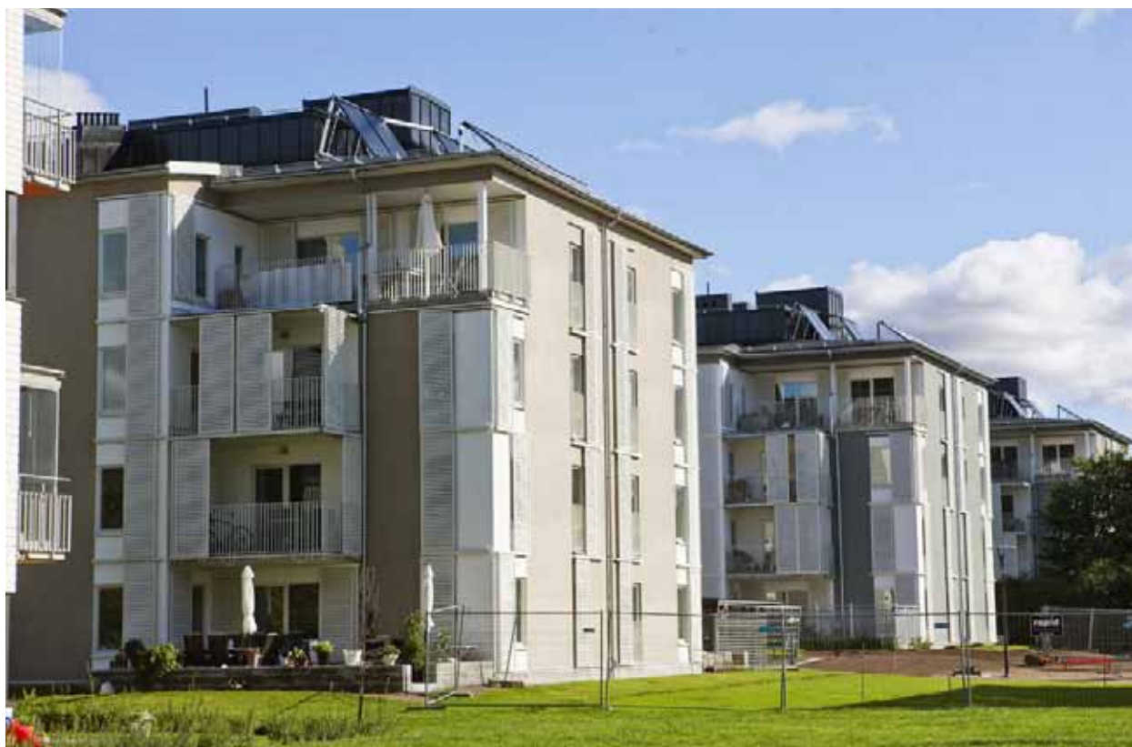
Lågenergihus i Beckomberga med solfångare på taket
