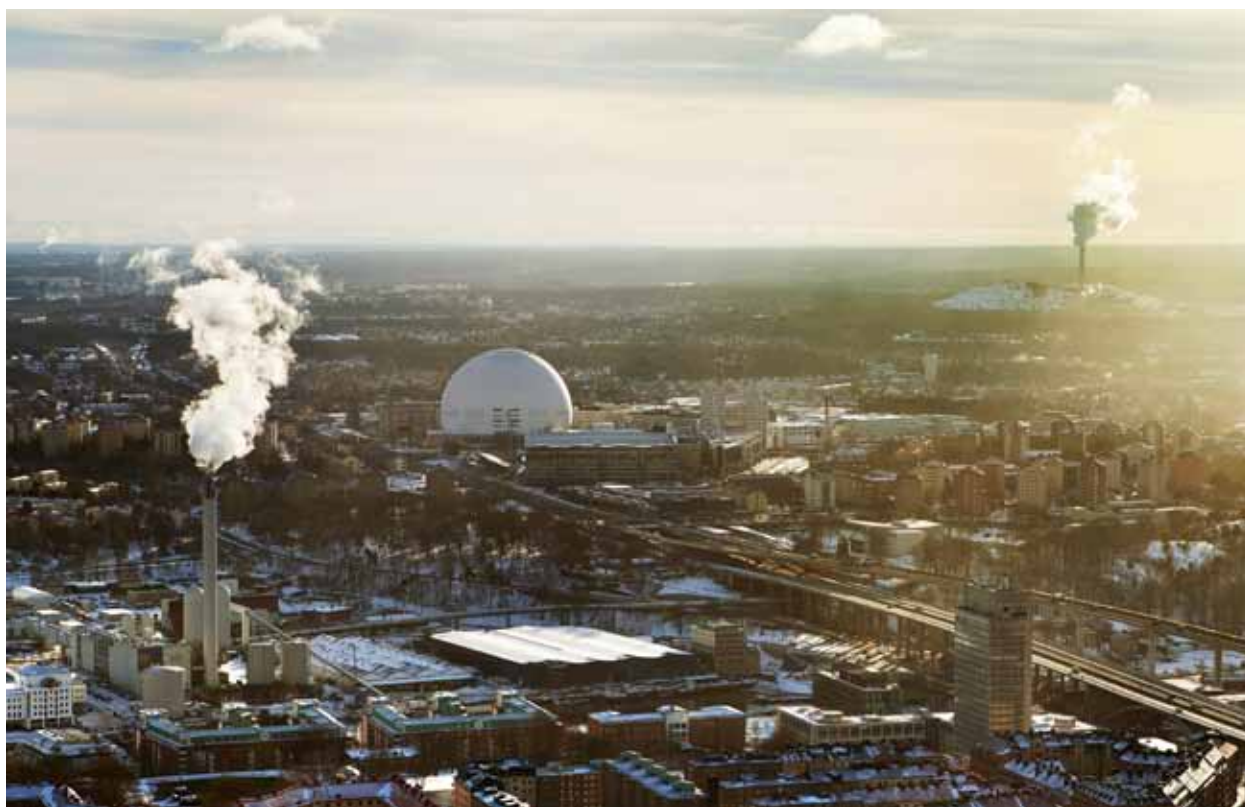
Hammarby värmeverk är en värmepumpsanläggning som hämtar värme ur renat avloppsvatten.
