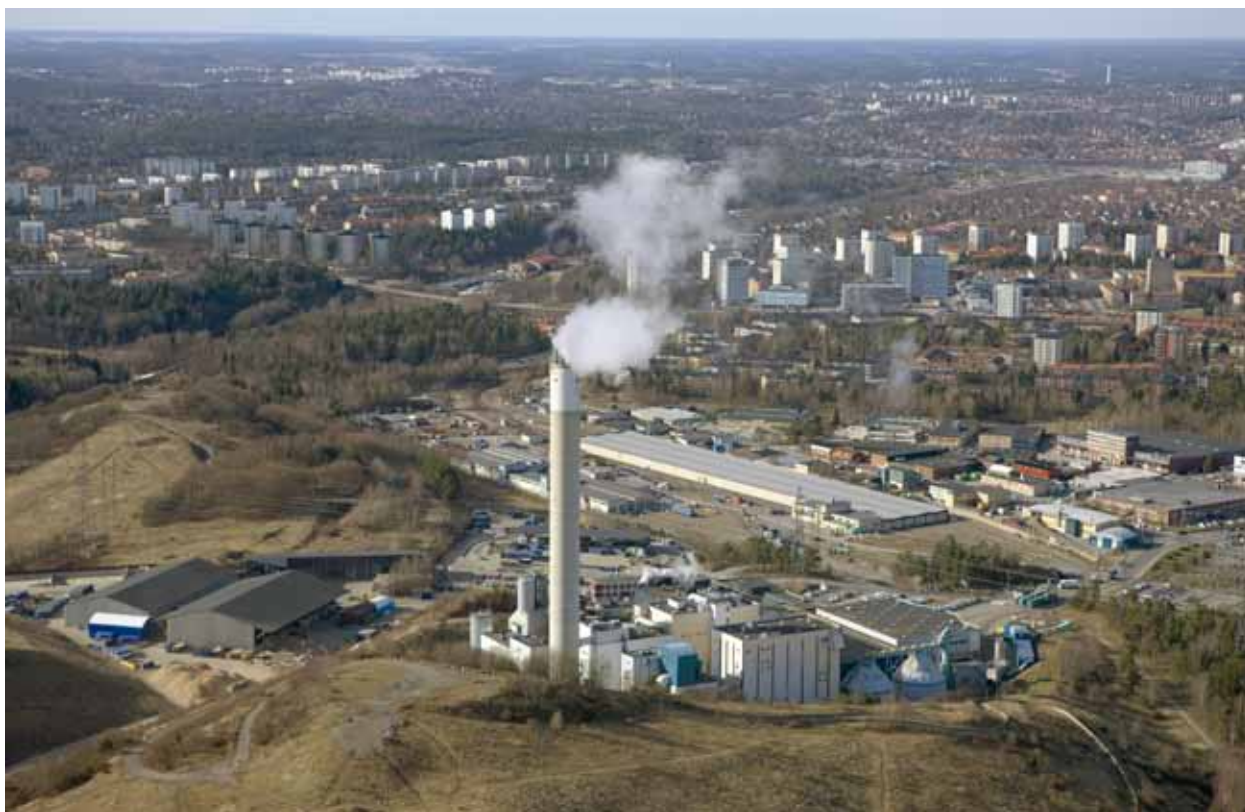
Högdalenverket är ett kraftvärmeverk som producerar både el och värme av främst hushålls och industriavfall.
