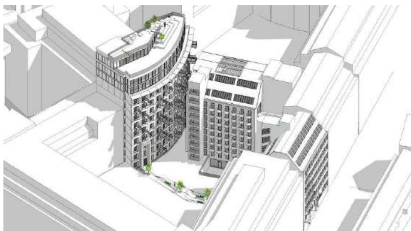
Blästern 14 efter planens genomförande, med balkonger, påbyggnad och restaurerad fasad. Sett från nordväst.
