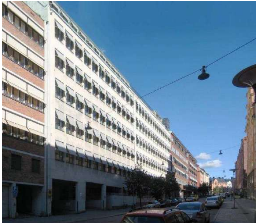
Fasad mot Gävlegatan, år 2013
