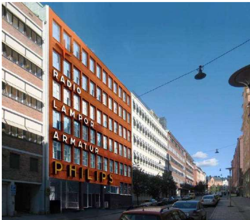
Fasad efter restaureringen
