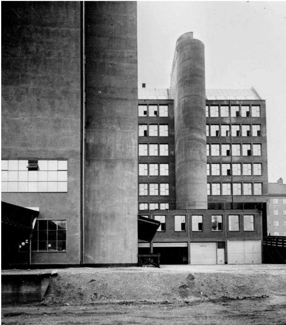
Foto av magasinets gavel och insidan på gathuset, som tydligt visar betongfasaderna med synliga gjutskarvar och spår av formbrädor. De kraftfulla tornkropparna innehöll hiss (magasinet) respektive trappa (gathuset).
