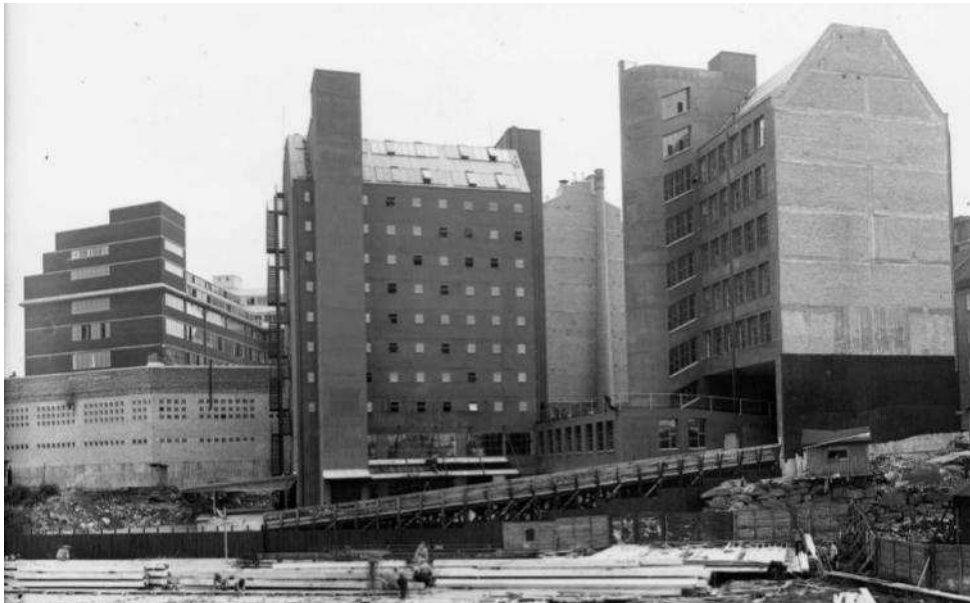
Philips anläggning från gårdssidan innan granntomterna hade bebyggts. Magasinet försågs med små kvadratiska fönster jämnt utspridda över fasadytan. Fönstren var av metall och placerade i ytterliv.
