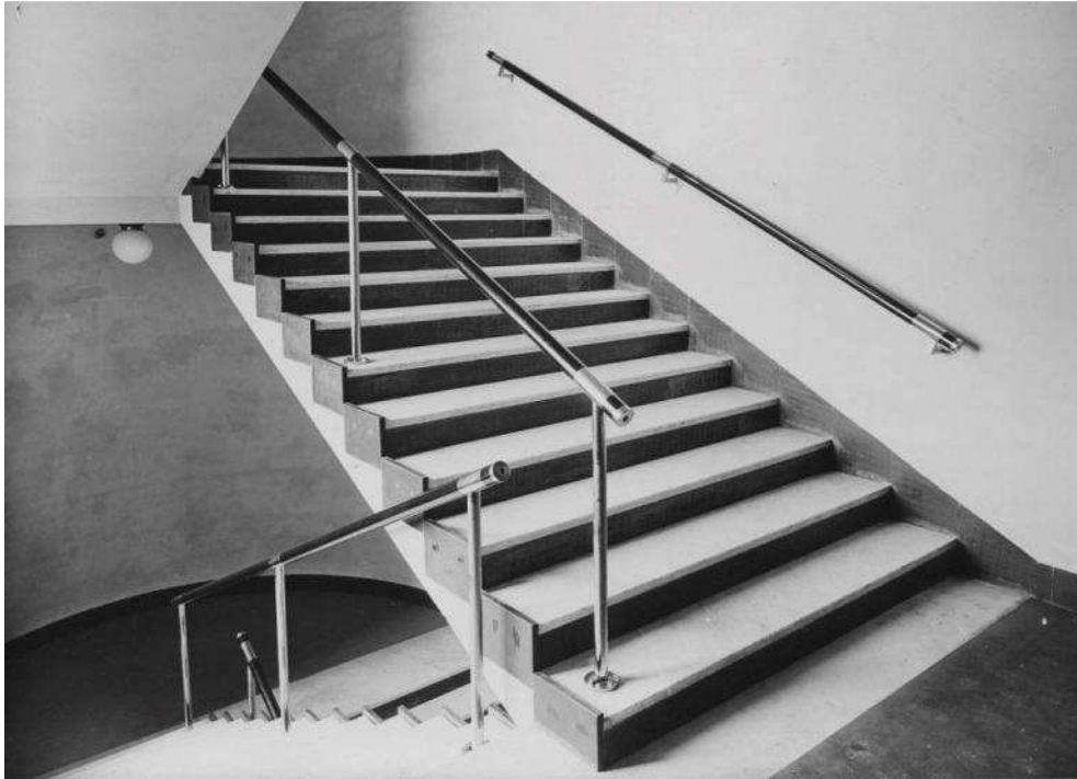
Trapphusinteriör med ursprungliga detaljer. Det eleganta trapphuset i gathuset, med marmortrappa och handledare av stål och mahogny, stod i skarp kontrast mot byggnadens industriellt präglade exteriör.
