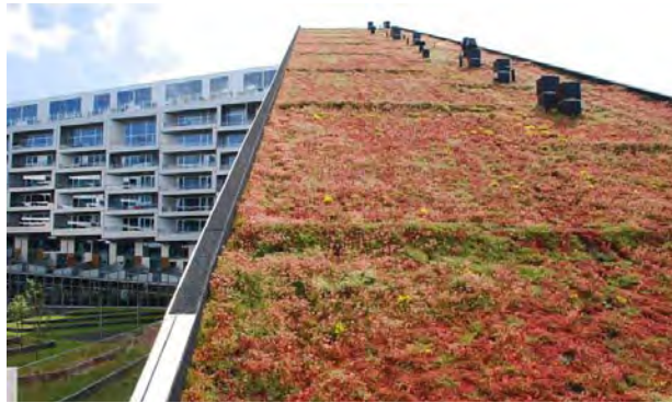
Referensbilder moss-sedum. Källa: Veg Tech AB
