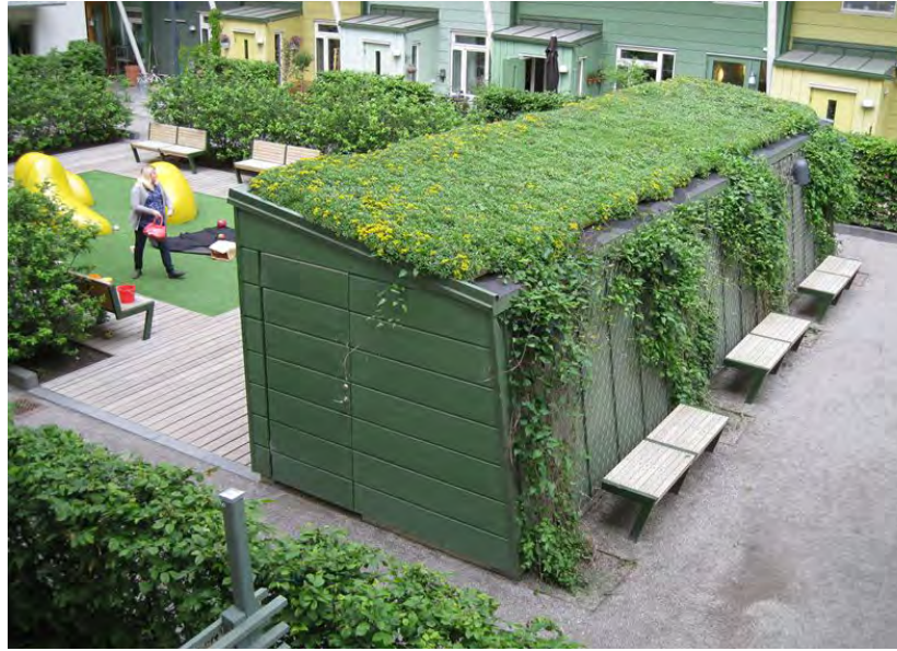
Referensbild fasadvegetation. Källa: Veg Tech AB
