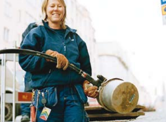
Åsa Wimarck, installationstekniker på Stokab, lägger en skarvbox i brunn.
