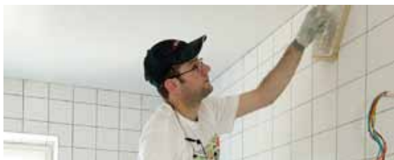
Nytt kakel sätts i ett badrum som helrenoveras i samband med stambyte.
