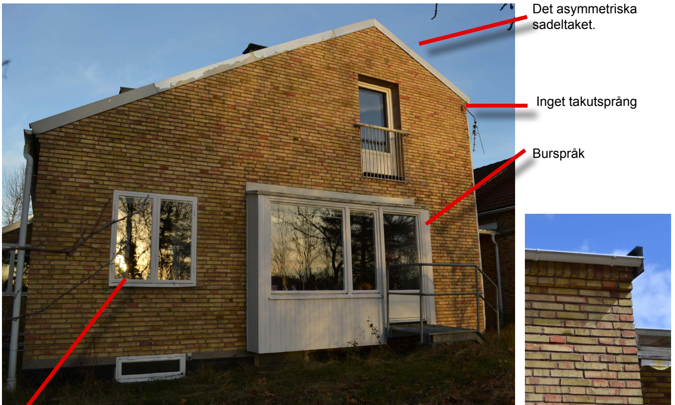
Fönster i liv med fasaden - tunna smäckra fönsterbågar i trä och inga fönsterfoder
