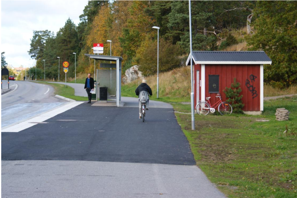
Cykelbana bakom busshållplats i Värmdö, Skärgårdsvägen
