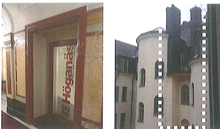
Vänster, befintlig dörröppning i entrén utnyttjas för anslutning till ny hiss. Höger, hissutbyggnadens läge i förhållande till befintlig gårdsfasad.
