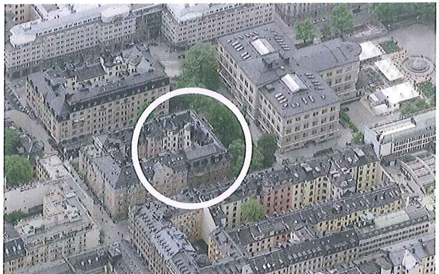
Befintlig kontorsbyggnad på Fenix 1 med omgivande bebyggelse
