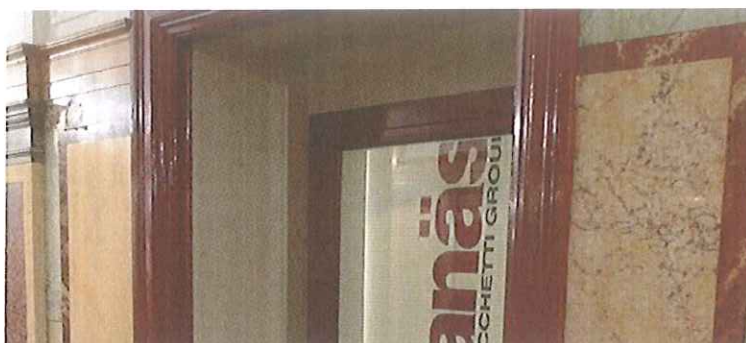
Väggutsnitt i entrén med intakta stucco lustro putsmålerier skyddas i planen med varsamhetsbestämmelser.
