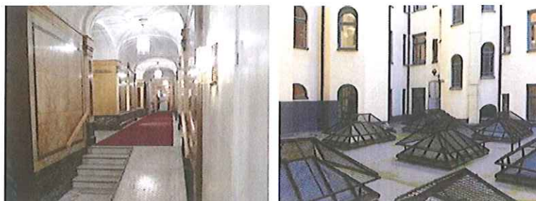
Vänster, befintlig entré med tillfällig ramp.
