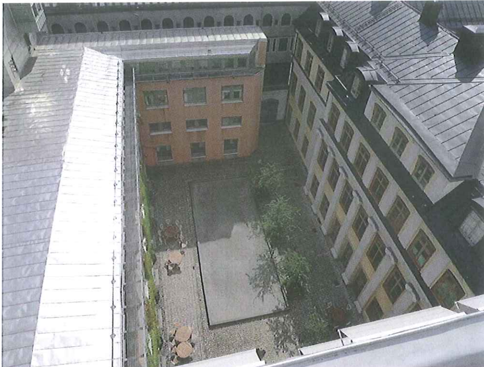
Vy över gården framför Adelerantzka palatset. Till höger syns Adelerantzka palatset och i fonden skimtar den portiköppning som leder ut till Karduanmakargatan. Den kontorsflygel som ansluter till portiken har ingen byggrätt i gällande detaljplan och är tänkt att rivas.
