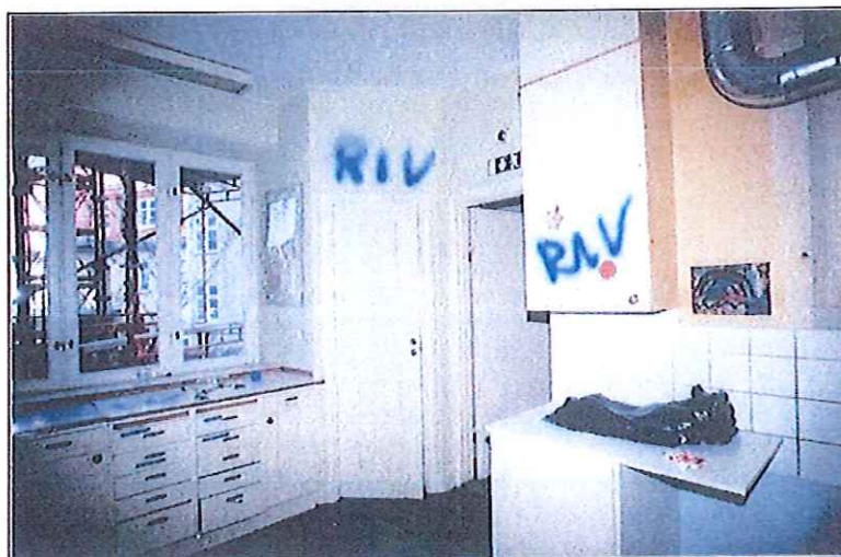
Före. Köket i södra delen för ombyggnaden, sett mot kökstrapphuset. Rum 020.
