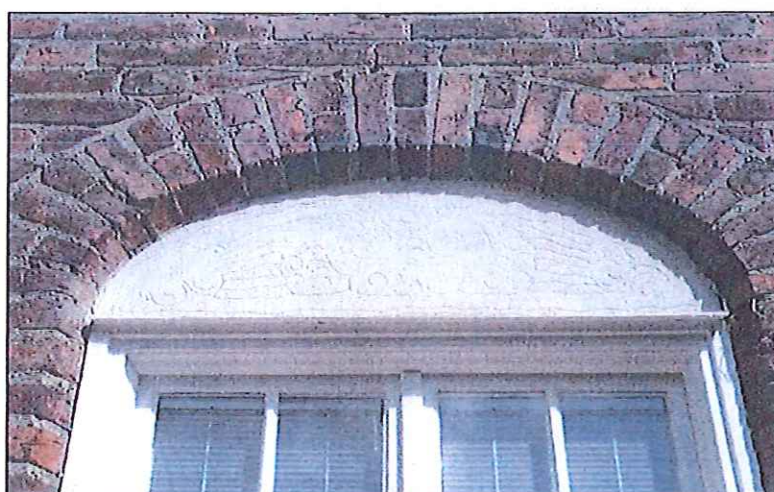
Överstycken på gatufasadens bottenvåning. Dekorationen i putsen, så kallade falsk sgrafitto, har renoverats.
