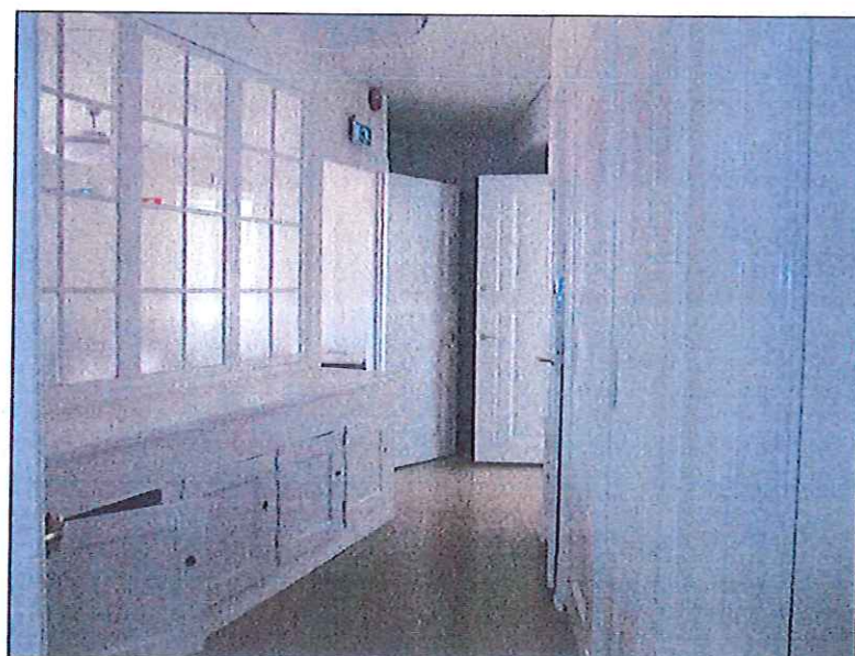
Efter renoveringen. Garderobsdörrarna till höger är återinsatta och döljer de nya schakten. Glaspartiet med bänken har bevarats. Rum 303B.
