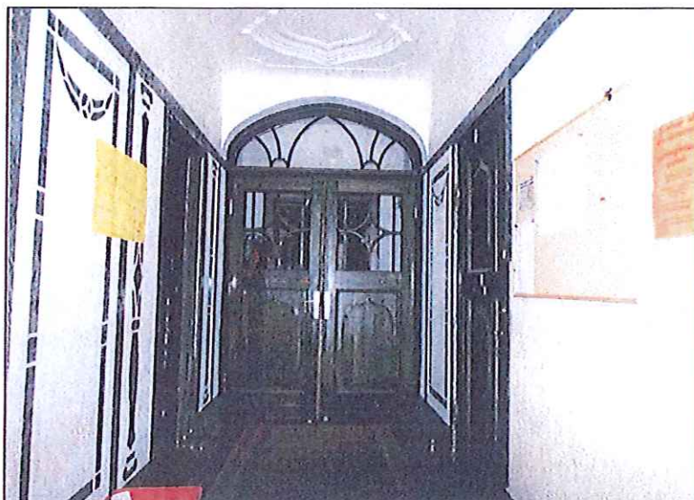
Bottenvåningens entré före ombyggnaden. Det glasade dörrpartiet har tagits bort men förvaras på vinden, väggarna har målats isamma kulör, dörren till vänster har ådringsmålats. Rum 001.
