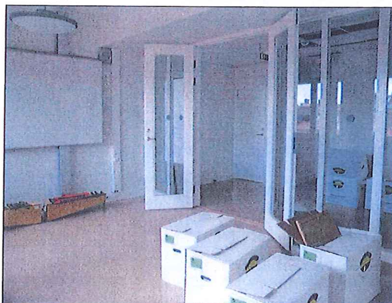
Samma vy efter renoveringen. Ett nytt glasparti har ersatt väggen mot korridoren. Rum 317.
