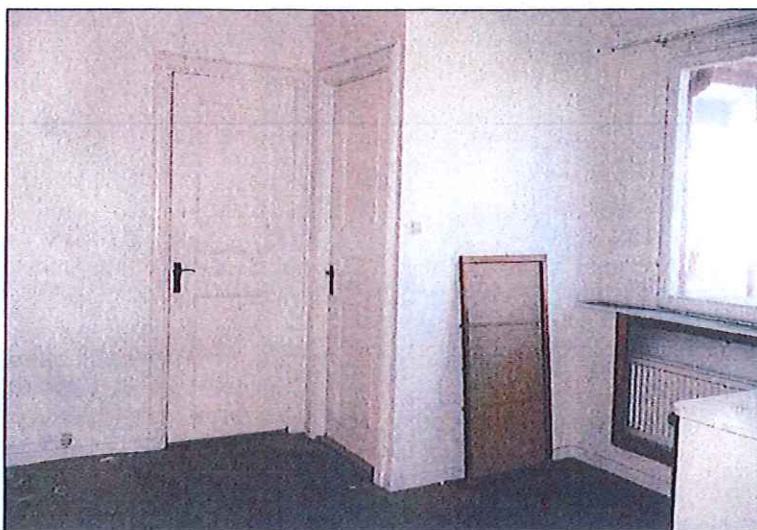
Före. Kök i norra delen, 3 trappor, dörr till kökstrappan. Rum 317.
