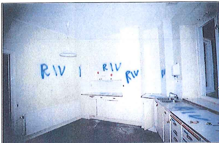
Före. Köket i bottenvåningens södra del före ombyggnaden. Rum 020.
