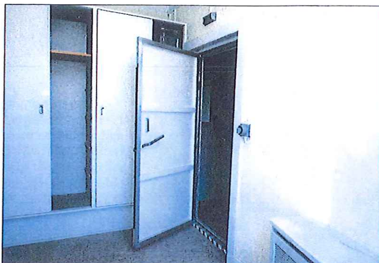
Före. Dörr till avlyssningsrummet låg i norra entréhallen. Rum 214 SBA 460-7
