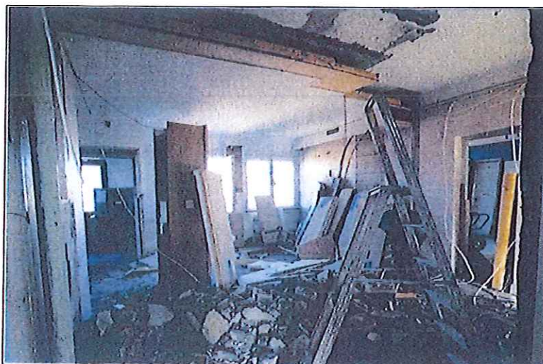
Under renoveringen av köket i norra delen, 3 trappor. Mellanväggarna mot korridoren utanför köket rivs. Rum 317.
