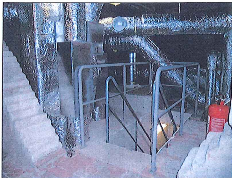
Ny trappa av stål.
