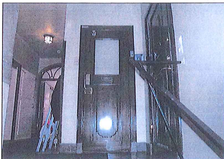
Ursprungliga hiss dörrar används inte längre men har bevarats på alla plan. Hissen nås efter renoveringen från motsatta sidan, inne på våningsplanen, inte från trapphuset.
