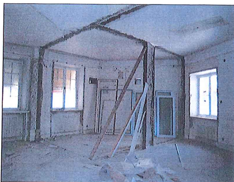
Efter rivning av sekundära mellanväggar i södra delen, bottenvåningen. Ursprungliga rumsvolymer blir synliga innan den nya planlösningen gestaltas. Rum 031-032.
