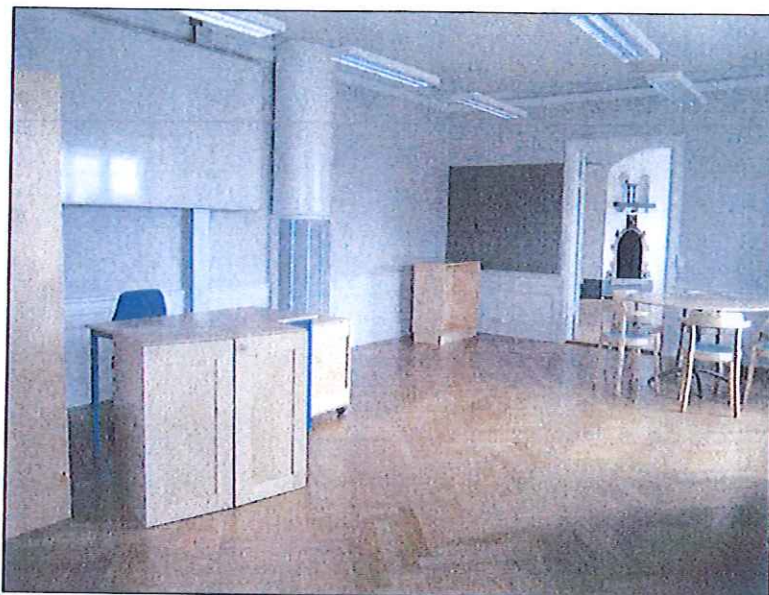
Efter, samma vy som ovan. För att undvika håltagningar i en eventuellt underliggande väggmålning har ventilationsdonet här lagts utanpå väggen. Rum 311B
