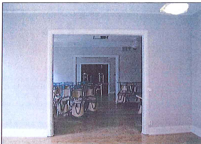
I bottenvåningens norra del, rummen mot gatan, har planlösningen inte förändrats. Ursprungliga parkettgolv har slipats och lackats. Från rum 002 mot 003 och 004.
