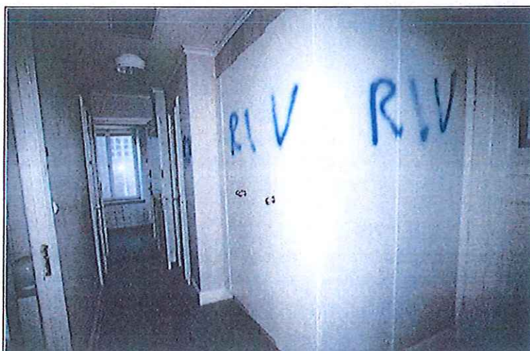
Före. Korridor vid kök, norra delen, 1 trappa. Nu del av rum 118.
