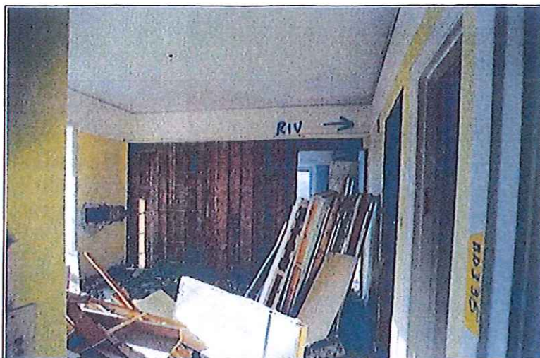
Före. Exempel på rivning av vägg mellan två rum. Del av rum 312
