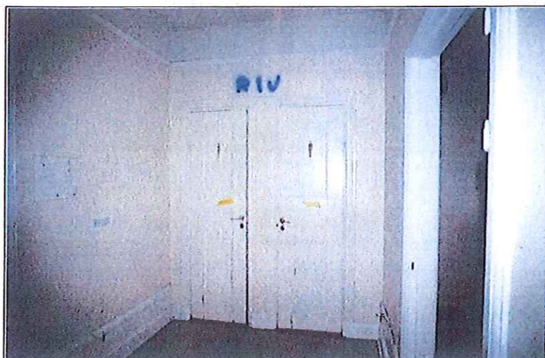
Före. Toaletterna på bottenvåningen, norra delen, bestod av två mindre rum. Rum 215.
