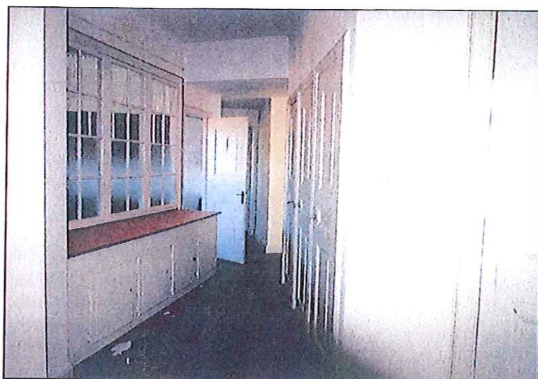
Före. Bevarade snickerier i serveringsgång, 3 trappor södra delen. Dessa snickerier utgjorde egentligen de enda bevarade ursprungliga kökssnickerierna. Rum 303B
