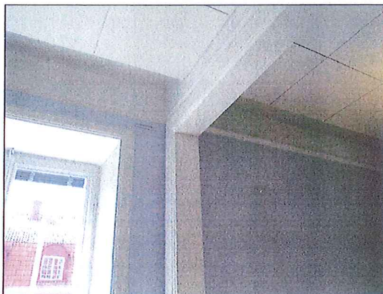
Efter renoveringen är järnbalkarna inklädda med lister och tavellisten kvar. Rum 218
