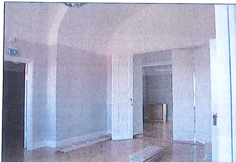
Efter, samma vy som ovan. Den öppna spisen har rivits. Nya kompletterande vikkörrar har tillkommit för att ge bättre ljudisolering mot rum 311A. Rum 321.
