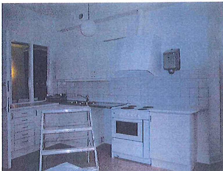
Samma vy som ovan efter renoveringen. En ny dörröppning till hallen syns längst till höger i bilden. Rum 020.
