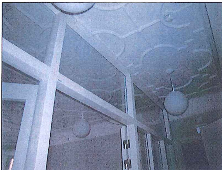
Den täta väggen har ersatts med en ny glasad vägg. Rum 116-117.
