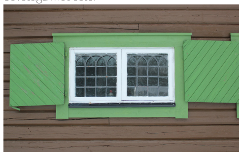
Fönster med blyspröjsade bågar och fönsterluckor.
