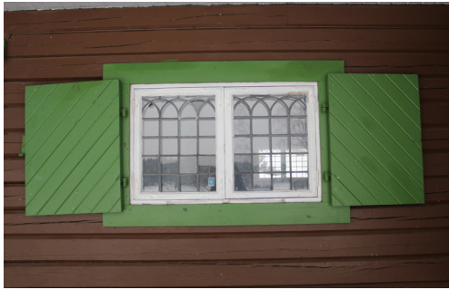
Fönster med blyspröjsar och fönsterluckor
