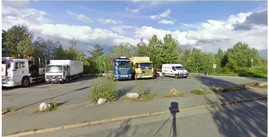
Bilden visar den lastbilsparkering som finns i anslutning till Granitvägen där den framtida infarten (via ramp) kommer att ske till parkeringshuset inom området. Bildkälla: Google Streetview.
