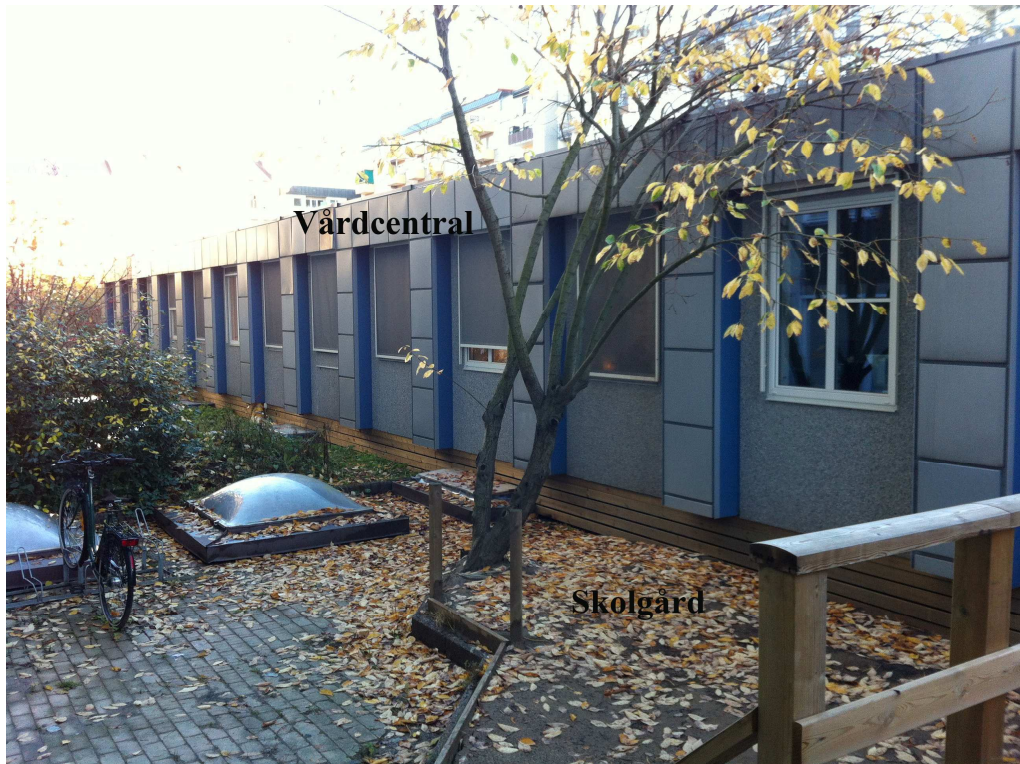
Vårdcentralens provisoriska byggnad på gården
