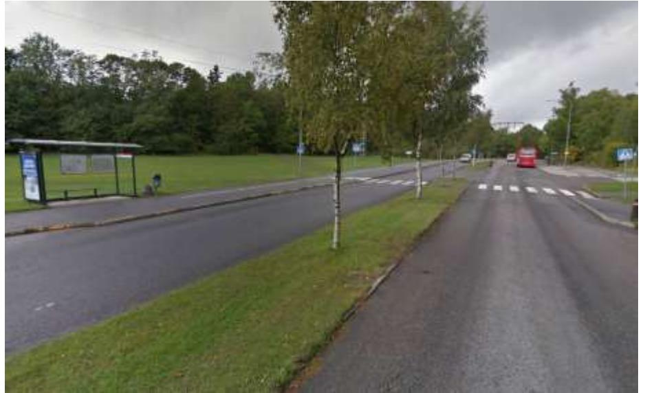
Bild 1. Sedumbacken före ombyggnad
