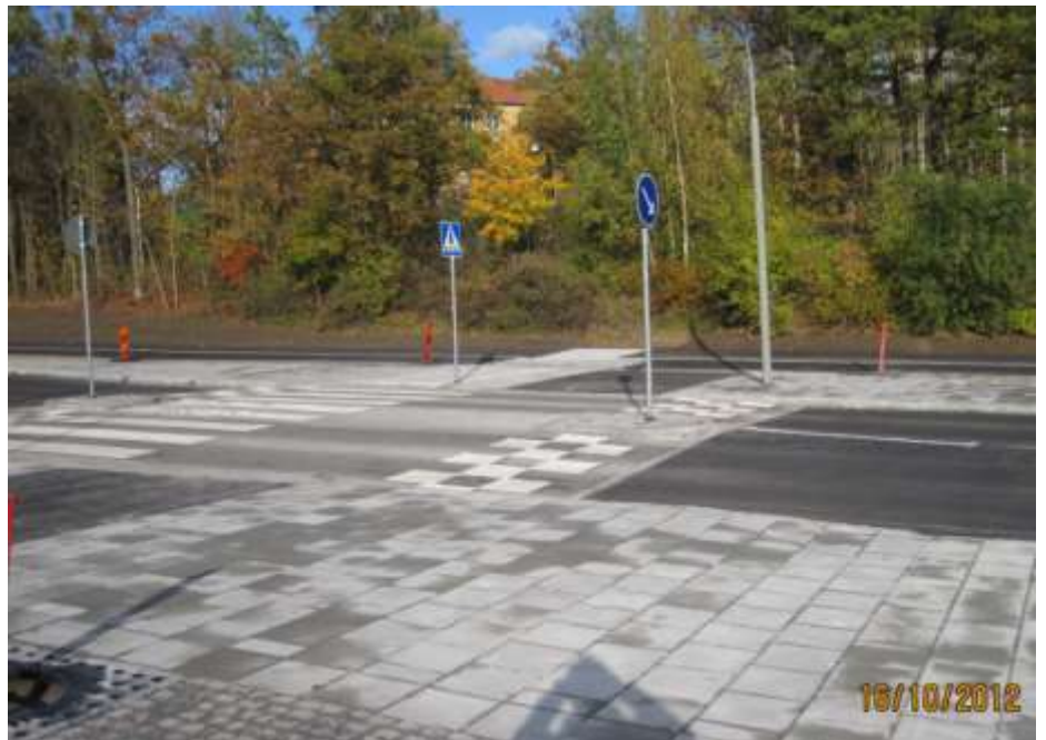
Bild 2. Sedumbacken efter ombyggnad
