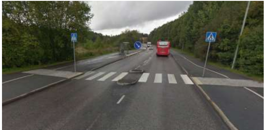
Bild 3. Kortenslunds koloniområde före ombyggnad
