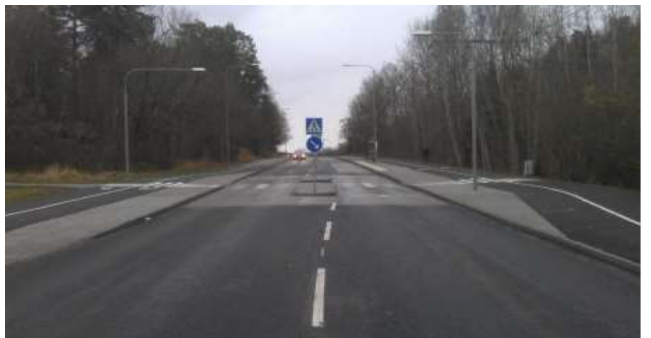
Bild 4. Kortenslunds koloniområde efter ombyggnad
