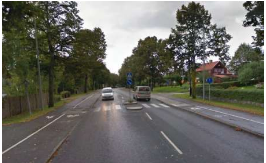
Bild 7. Urban Hjärnes väg före ombyggnad
