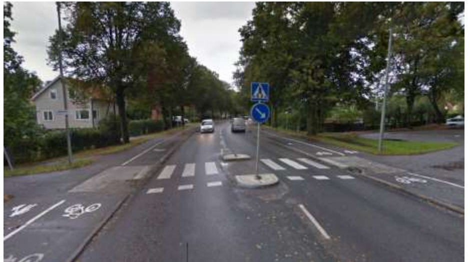
Bild 9. Rundkyrkoallén före ombyggnad
