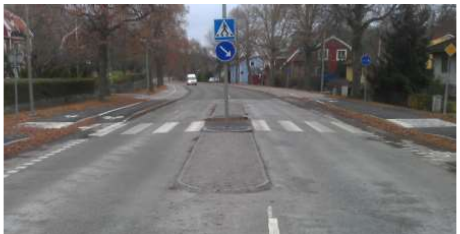
Bild 8. Urban Hjärnes väg efter ombyggnad
