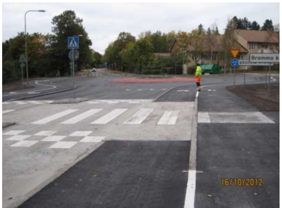
Bild 6. Bromma kyrkväg efter ombyggnad
