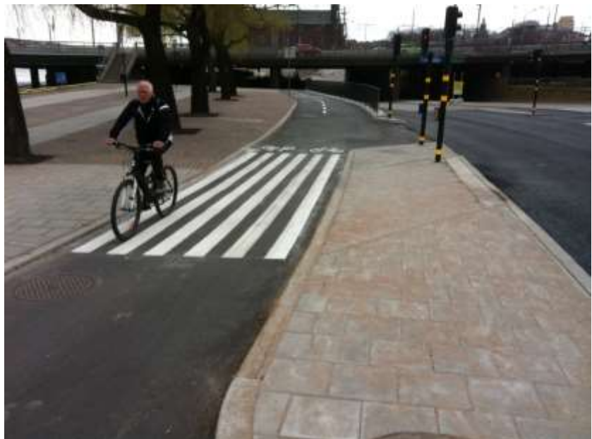
Den tillstängda och otillgängliga entrén mot sjösidan har öppnats upp och blivit mer inbjudande och höjdskillnader har tagits bort. Stödmuren mot Tegelbackens tråg under Centralbron har flyttats ut för att skapa mer plats och ge större kurvradie på cykelbanan. Cykelöverfarten i korsningen med Vasagatan har breddats.
