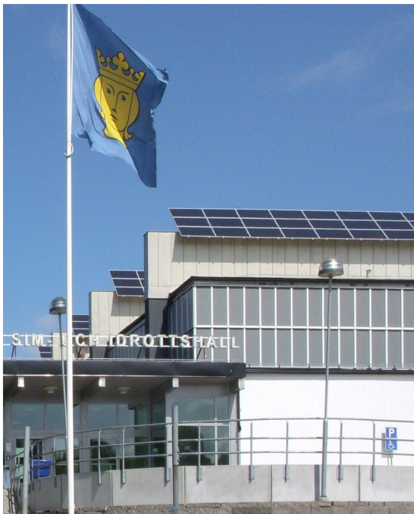
Figur 6: Åkeshovs sim- och idrottshall, Stockholms stads första idrottsanläggning med solcellspaneler uppförd år 2007 med en elproduktion på 45 MWh per år.
