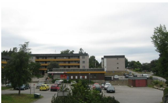
Figur 9 Befintlig bebyggelse vid planområdets södra del, Markörplan: bostadsbebyggelse i fyra våningar och centrumbyggnad med bl.a. livsmedelsaffär i en våning.
