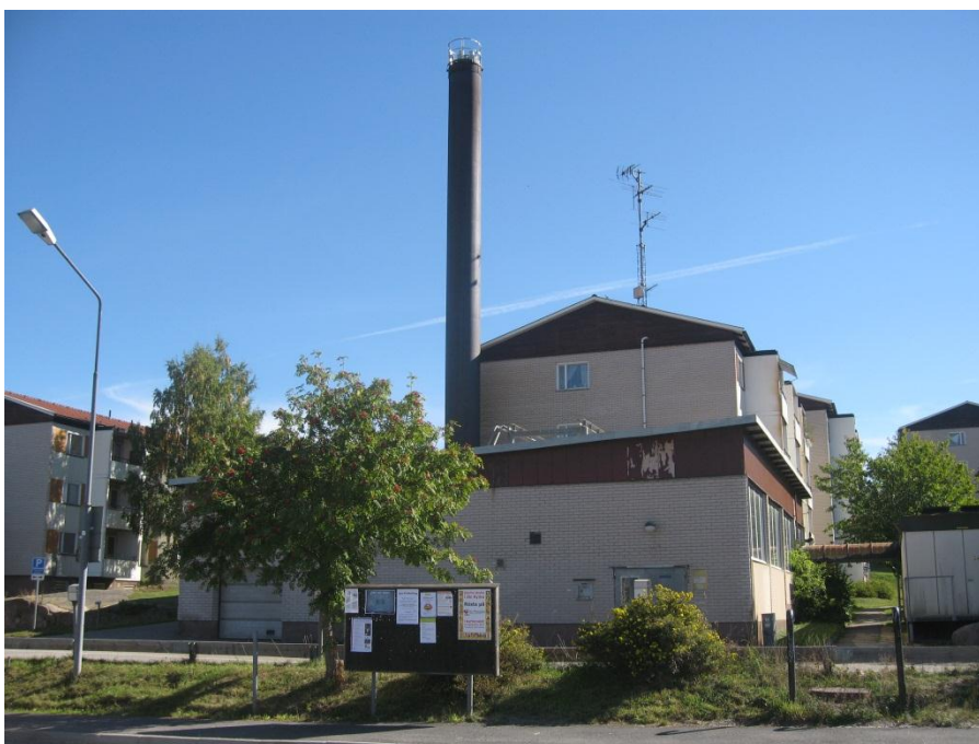
Figur 55 Panncentralen längs Skyttevägen i Munkmora
