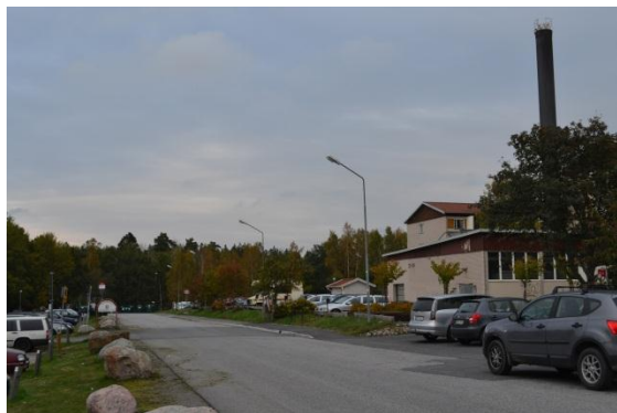
Figur 24 Före: Från Skyttevägen norrut mot planområdets norra del.
