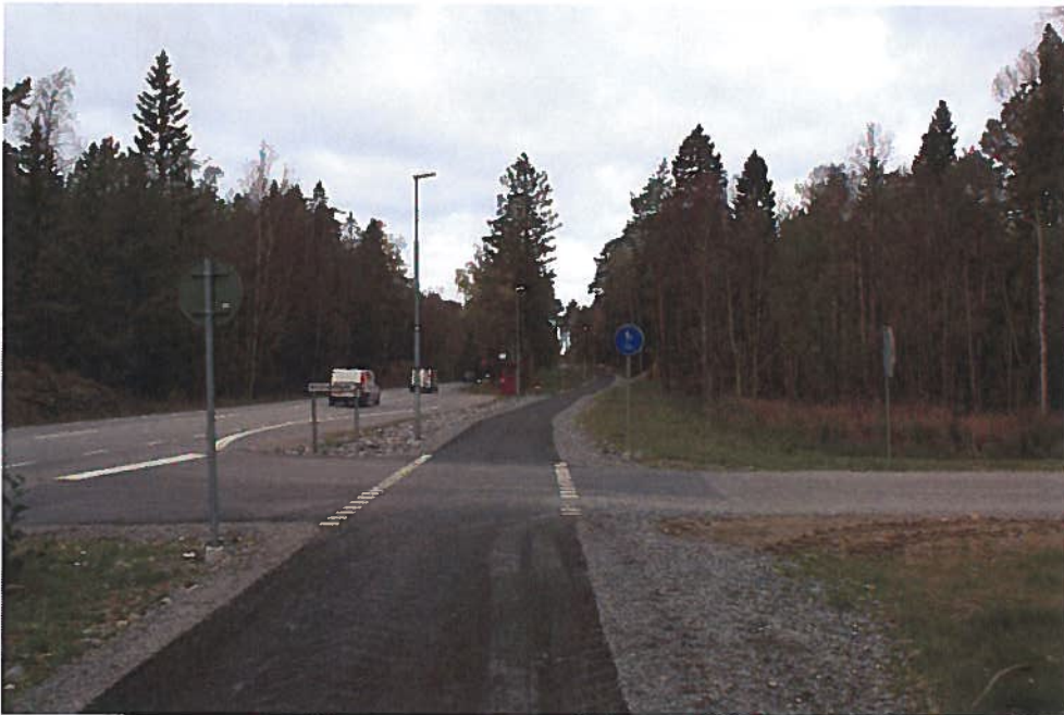
Nybyggd kommunal GC Strömma-Ålstäket vid Rödingstigen. Vägen bör förses med mittlinje och cykelmyror
