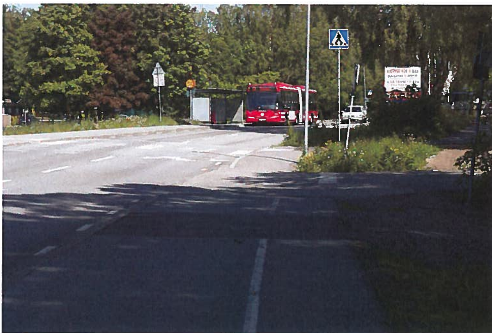
Otydlig passage i Björkås över utfart och väg 686
