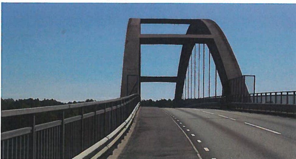
Gång- och cykelväg över Djuröbron
