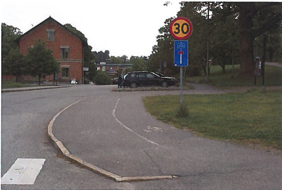
Slutet på det regionala cykelstråket Nacka-Värmdö vid Gustavsbergs kyrka. Otydlig mittlinje och slitna cykelmyror. Det ligger även kantsten i cykelstråket. Med små åtgärder kan säkerheten öka
