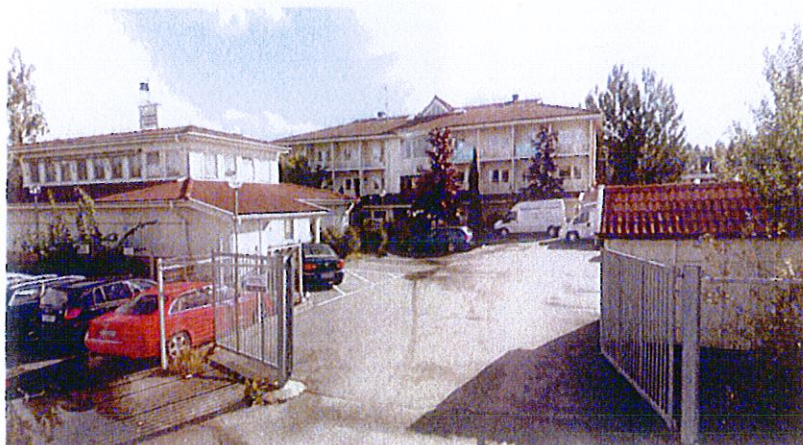
Fastigheten sedd från nordväst.
