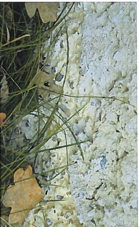
Trolig ursprunglig puts med rundad rödaktig sjösten som ballast sticker fram under den nuvarande.
