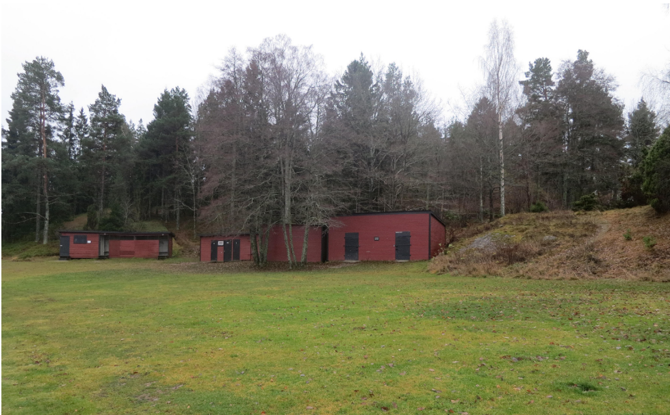
Befintliga omklädesrum, toalett och förråd
