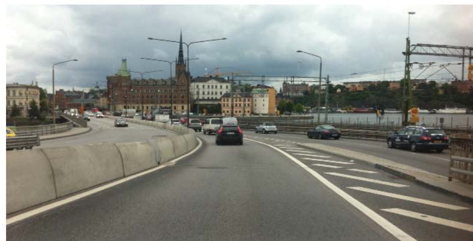
Centralbron: Vägen bedöms ha både väggar och golv av karaktären transportrum.
