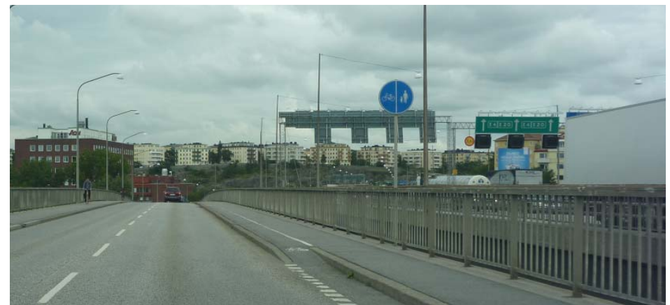
Gamla Essinge Broväg: Cykelbanan är smal och har därför inte bedömts vara fullgod separering. Sträckan har klassats med DTSS gc/bil.
