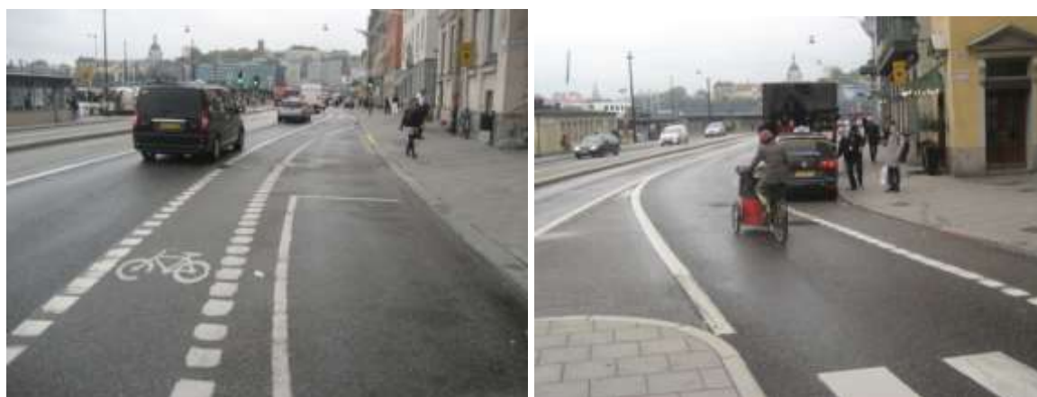
Bild 10. Västra sidan Skeppsbron: Bredden mellan cykelbanan och lastplatserna är otillräcklig för att skydda mot öppnande bildörrar (till vänster); felparkerade taxifordon tvingar ut cyklister i vägbanan (till höger).
