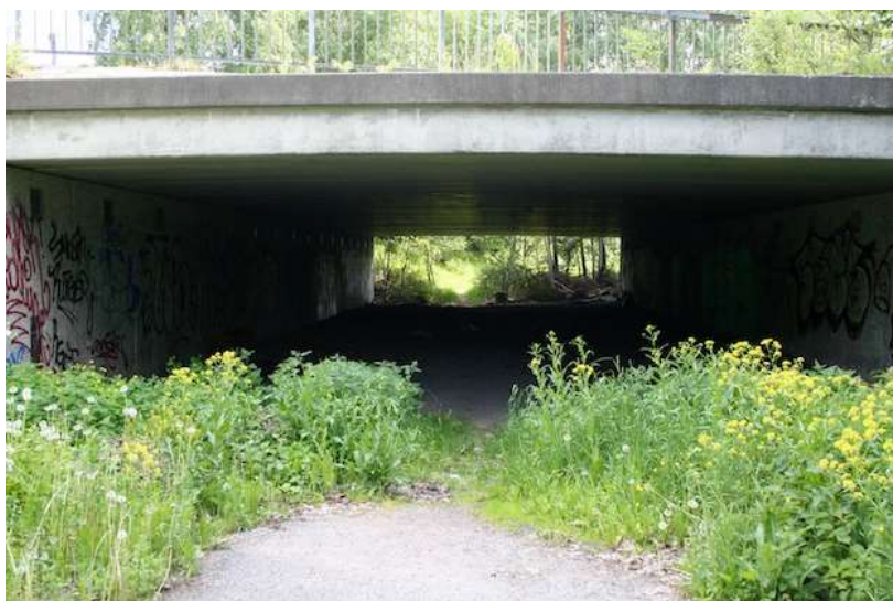
Bild 17. Gång- och cykeltunneln under Skärholmsvägen.
