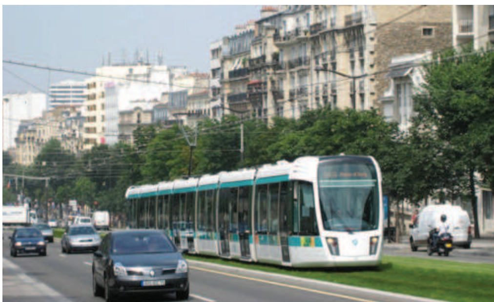
Figur 10. Spårväg i Paris på egen bana, vilket borgar för hög framkomlighet och god driftsekonomi. Foto: PG Andersson
