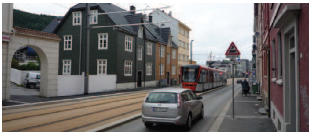
Figur 8. Längs Bybanen i Bergen ges spårvägen egen bana som tydliggörs genom nivåskillnad och avvikande färg. Korsningar med biltrafik är rödfärgade och korsningar med gångtrafik grå. Foto: PG Andersson
