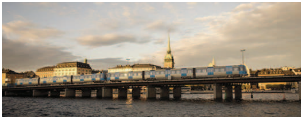
Figur 25. Tunnelbana mellan Slussen och Gamla stan. Källa: SL
