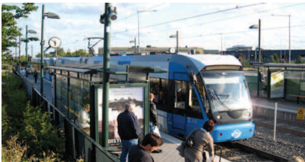
Figur 26. Tvärbanan station Årstaberget. Foto: PG Andersson
