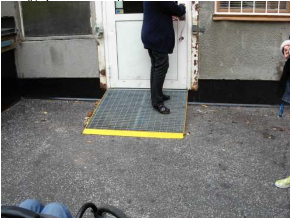
Ramp vid entrén på Duvnäsgratan
