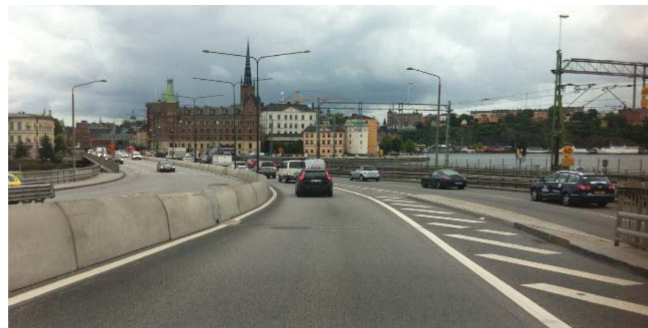
Centralbron: Vägen bedöms ha både väggar och golv av karaktären transportrum.
