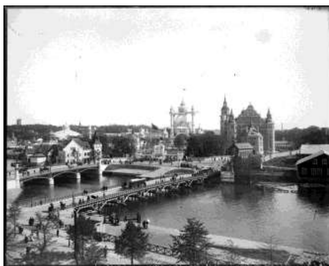
Fotografi över Djurgårdsbron samt den provisoriska träbron.
