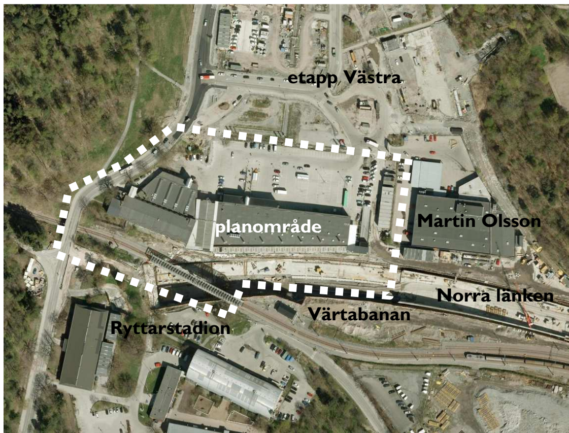
Ortofoto över planområdet (2010) under byggandet av Norra länken
