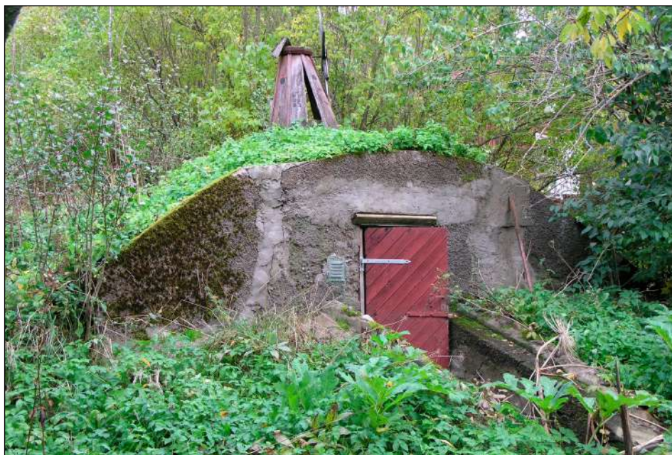
Gjuten jordkällare vid Holländartorp
