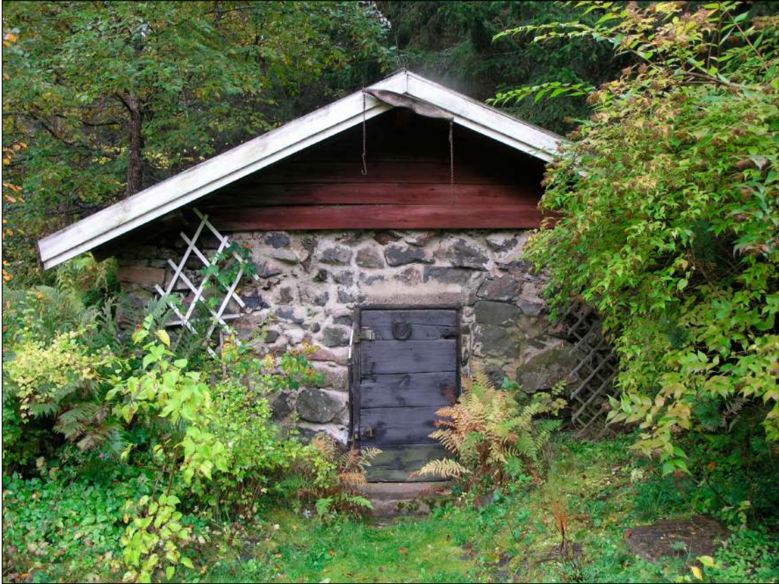
Källarbyggnad murad i natursten.
