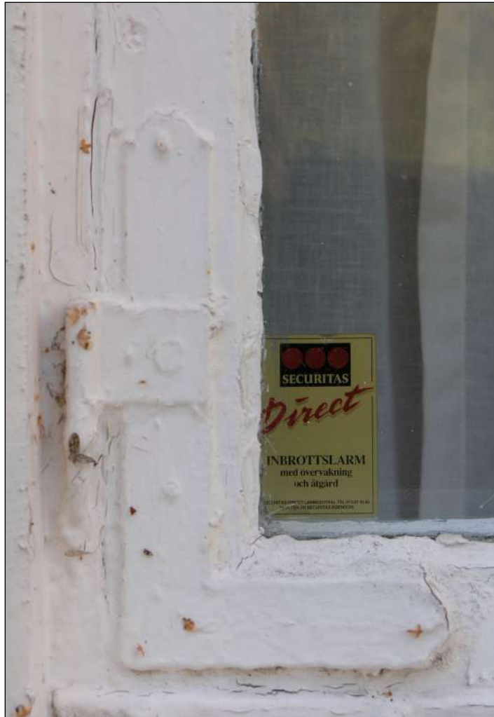
Fönsternas gångjärnsbeslag av sen 1800-talsmodell.
