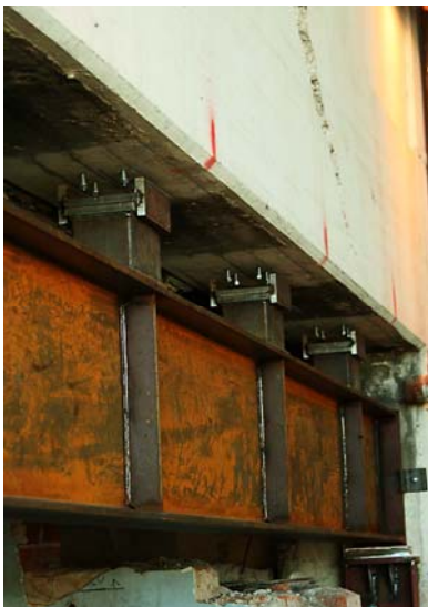
Bild 2.3: En stålbalk monteras vid allvarliga försvagningar där bärande balkar riskerar att brytas. Bild från Stadsgårdsleden
