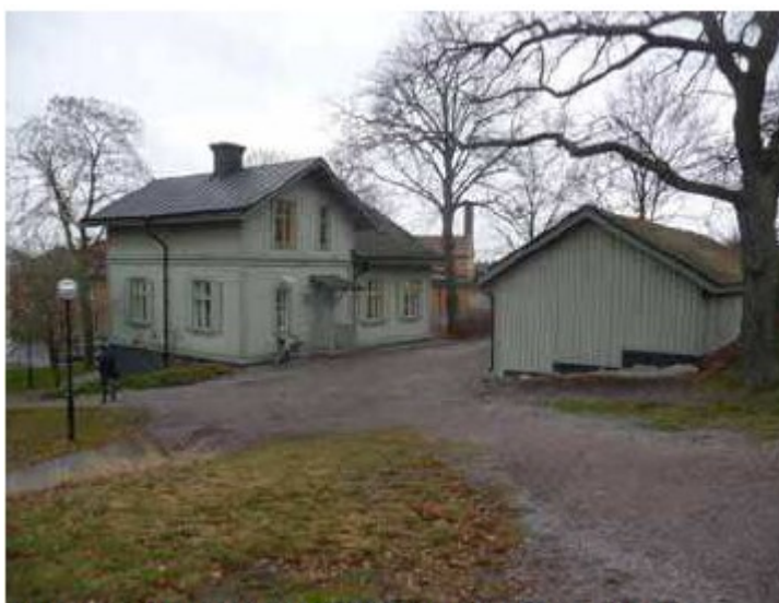
Bilden visar hovjägarbostället. Foto: Nivå och Per Nelson byggnadsvårdbyrå
