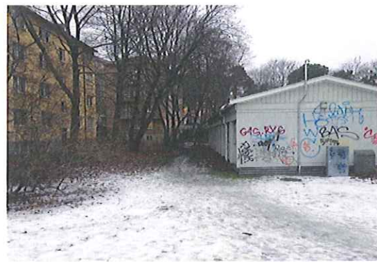
Elnätstationen byggs till vänster i bild
