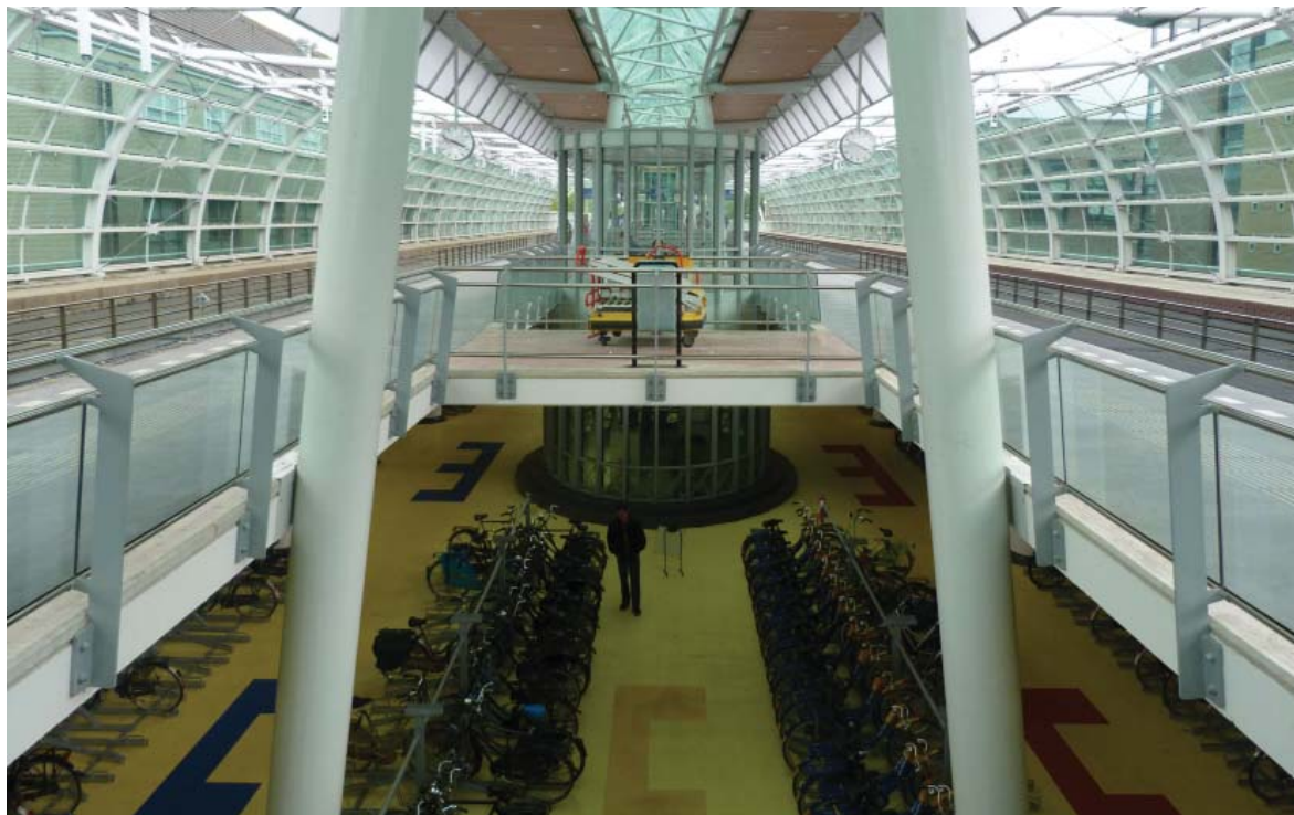
Vy från tågplattform. Hiss och trappor leder direkt ner till cykelparkeringen. Allt för att skapa enkel omstigning och göra kombinationsresor enkla och attraktiva.
