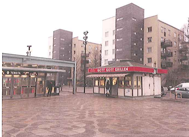
10. Detta gatukök i Tensta är ca 30 kvm och är anpassad till den storskaliga miljön vid tunnelbanan och höghusen. Detaljplanen anger att området får användas för centrumbebyggelse.
