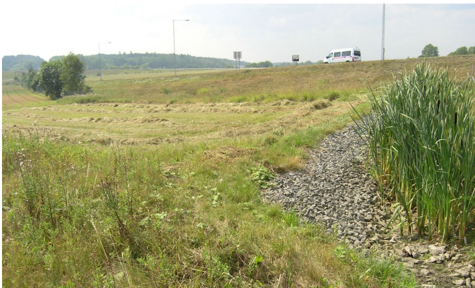
Figur 15. Exempel på en översilning för dagvatten, Kvisthamra Norrtälje.
