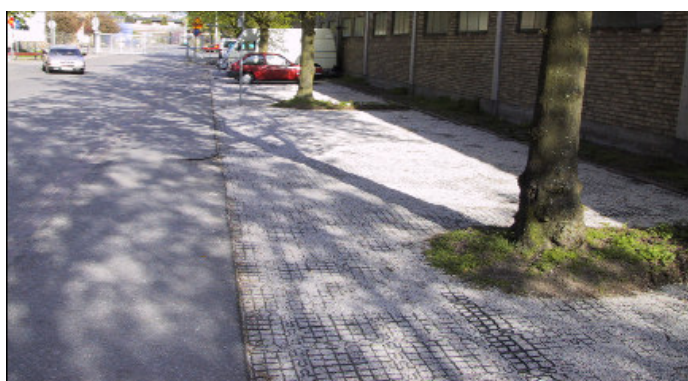
Figur 11. Genomsläpplig beläggning i form av plattor och raster. Foto ovan WRS Uppsala AB, nedan Ulf Thysell, VASYD/Malmö stad.
