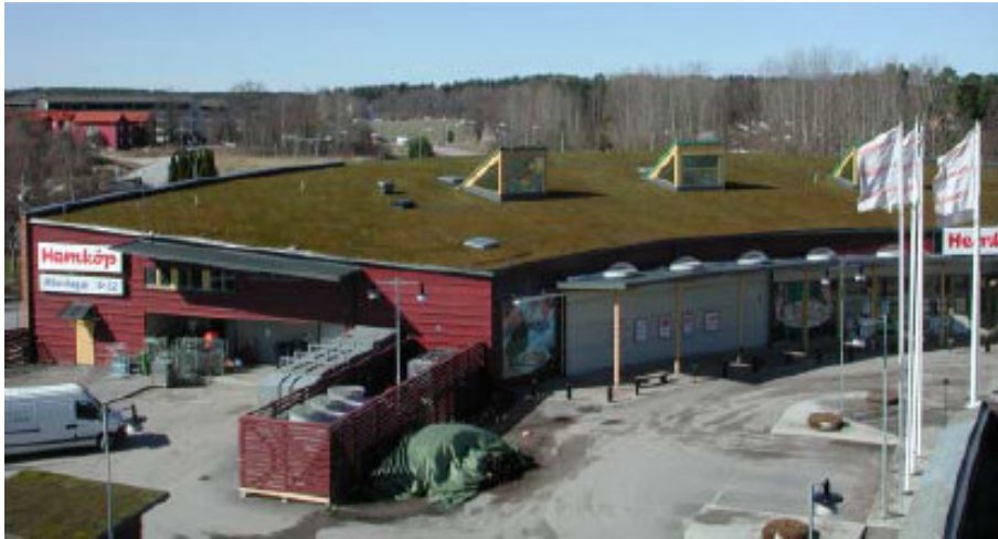
Figur 9. Moss-sedumtak på Hemköp i Upplands Väsby. Foto: Andreas Jacobs, Täby kommun/Oxunda Vattensamverkan.
