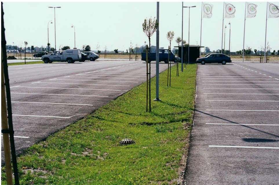
Figur 10. Svackdike på parkering i Svågertorp, Malmö. Asfaltytorna lutar mot svackdiken dit dagvatten leds av. Ofta anläggs dessa diken med ett genomsläppligt grusmaterial under matjorden och en dräneringsledning i botten. Föroreningar avskiljs då vattnet infiltrerar ner i jordprofilen. Kupolsilen i dikets mitt är endast ett bräddavlopp. Foto: Ulf Thysell, NSVA.
