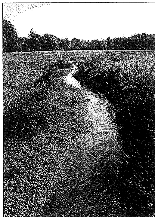
Vid Laduviken har en damm och ett öppet dagvattenstråk anlagts för att minska tillförseln av förorenande ämnen som kommer med dagvattnet. Foto: Magnus Sannebro.
