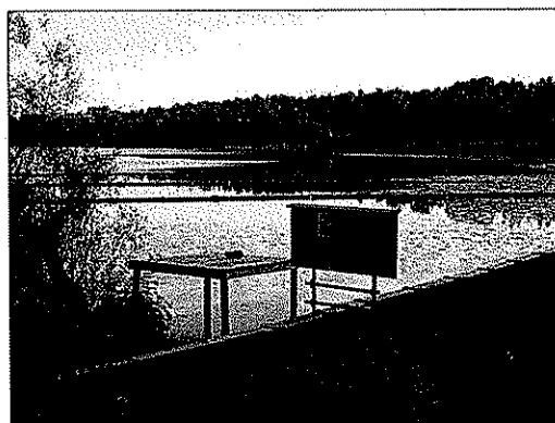
Vid Drevvikens nordvästra ände har en skärmbassäng anlagts som renar dagvatten. Foto: Magnus Sarnebro.
