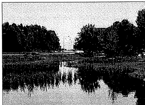
Vid Bergslagsplan i Grimsta har en reningsanläggning för dagvatten byggts, bestående av tre sedimentationsdammar och en våtmarkszon. Det renade dagvattnets leds sedan till Räcksta Träsk. Foto: Agata Banach, Sweco.
