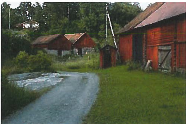
Hus med längdfasad mot gata.
