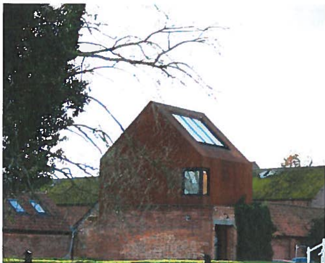
Stora takfönster (Howard Tomkins).
