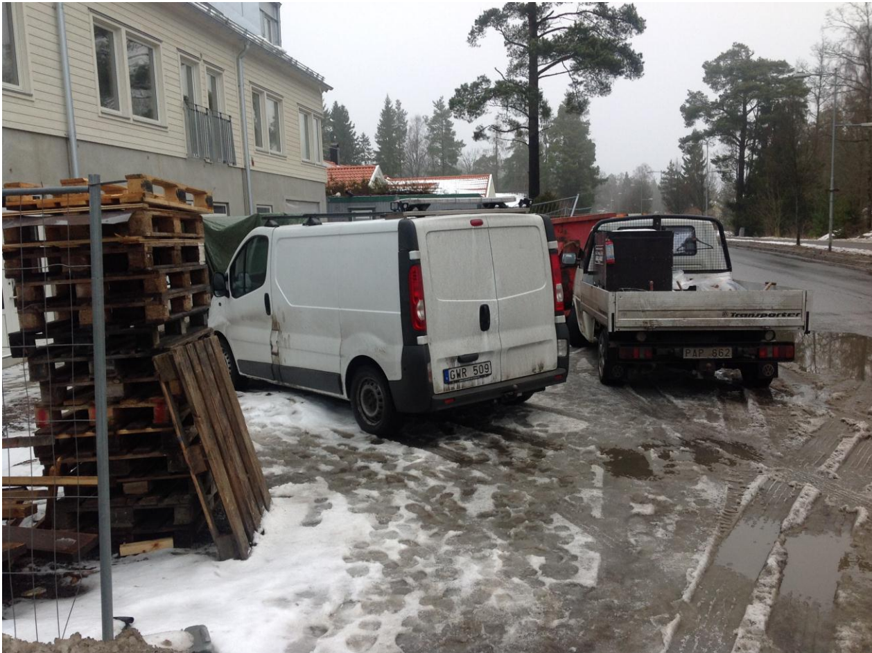
Bilden ovan: Byggnaden under uppförande. Angöringsyta mot Strandallén februari 2014. Lokaler och verkstad i bottenplan. Bostäder i övre plan. Utanför fastighetsgränsen på Strandallén, planeras en ny busshållplats. (Bild Tyresö kommun).
