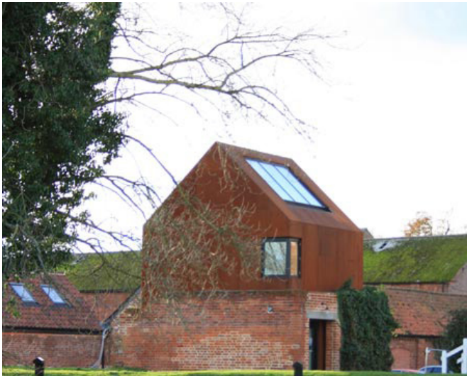
Stora takfönster (Howard Tomkins).
