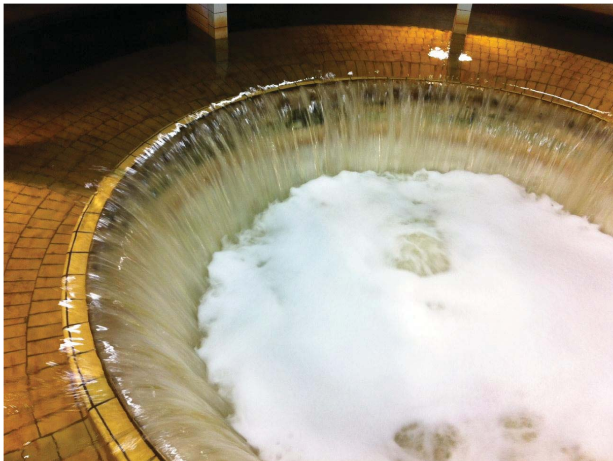
Utloppet från Henriksdals avloppsreningsverk. Foto: Joakim Lücke
