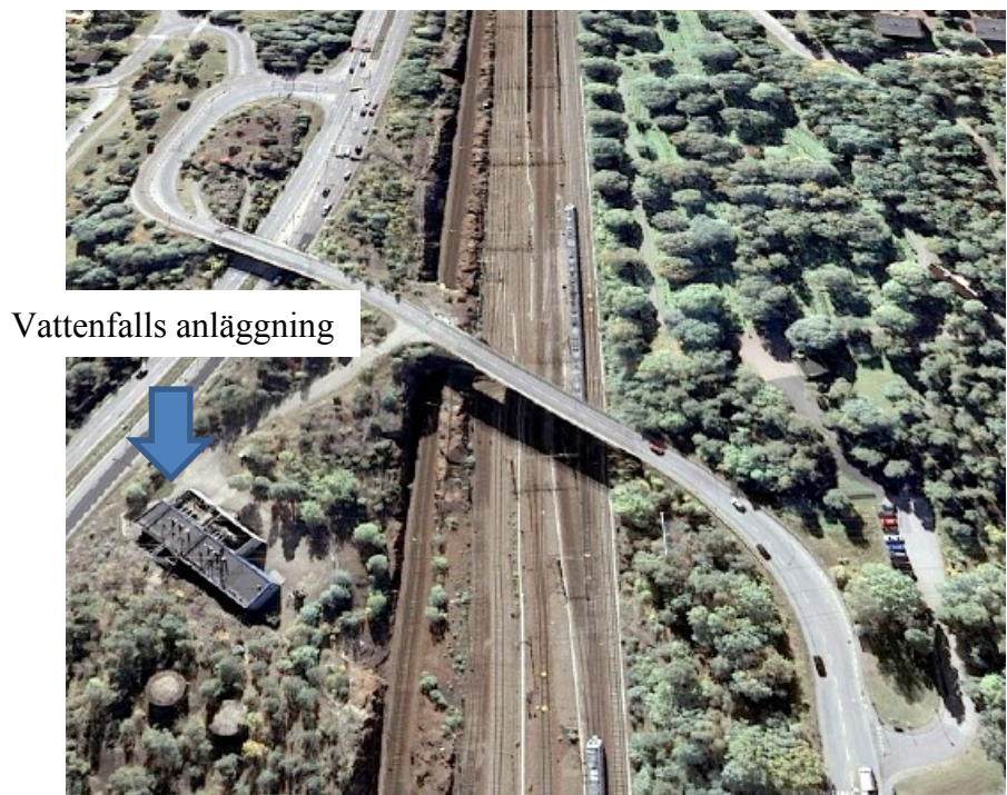
Broar över Åbyvägen och järnvägen, vy mot söder
