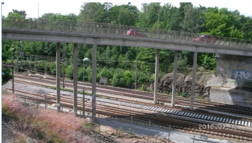
Bron över järnvägen sedd norrifrån
