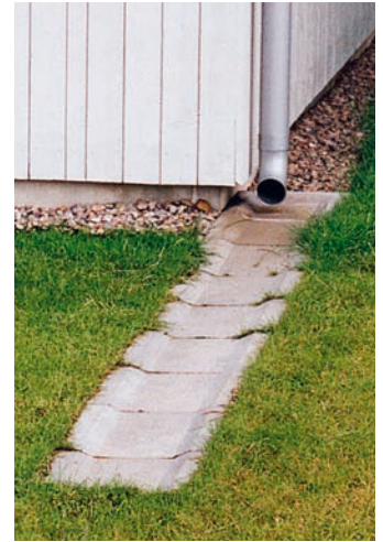
Gräsförsedd rasteryta för bibehållande av genomsläpplighet (Sweco). Stuprörskastare för infiltration på gräsmatta (källa: Peter Stahre, 2004, En långsiktigt hållbar dagvattenhantering, Svenskt Vatten. Foto: Ulf Thysell).
