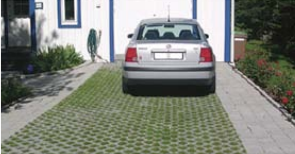
Gräsförsedd rasteryta för bibehållande av genomsläpplighet (Sweco). Stuprörskastare för infiltration på gräsmatta (källa: Peter Stahre, 2004, En långsiktigt hållbar dagvattenhantering, Svenskt Vatten. Foto: Ulf Thysell).
