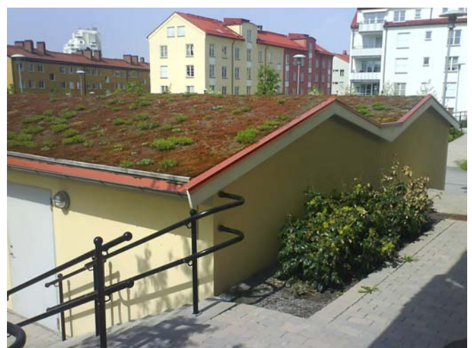
Gröna tak på garagebyggnader (Sweco).
