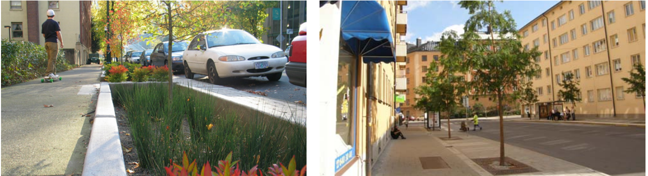
Växtbäddar för gatudagvatten (Okidoki). Trädplantering dit dagvatten från tak och trottoar leds (Trafikkontoret).
